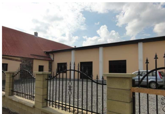
foto: Měčín – výstavba kulturně společenského centra
