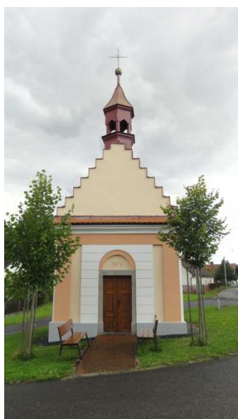
foto: Bíluky, kaplička – oprava fasády a výměna střešní krytiny
