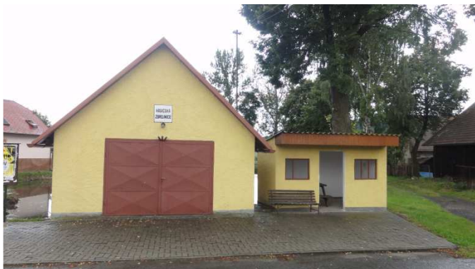
foto: Nedanice, hasičská zbrojnice – oprava fasády
