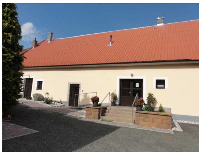
foto: Měčín – výstavba kulturně společenského centra
