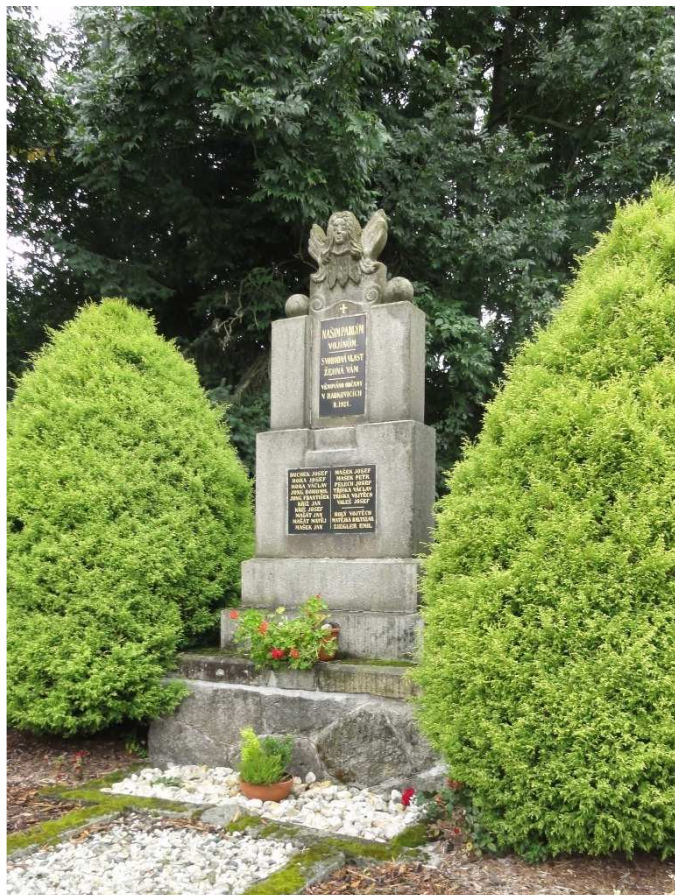
foto: Radkovice – rekonstrukce a okolní úpravy pomníku padlých
