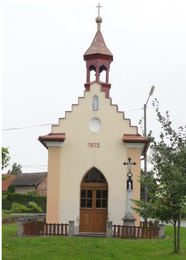
foto: Bílky, kaplička – oprava fasády a výměna střešní krytiny
