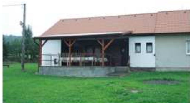
foto: Nová střecha a pergola na Kontíku v Třebýčíně
