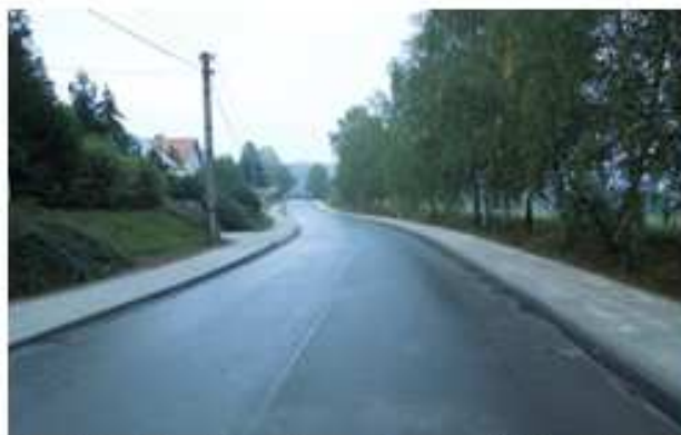
foto: Nové chodníky a komunikace v ulici Školní
