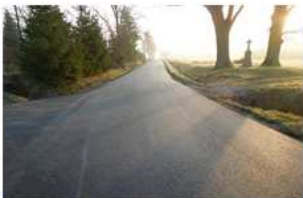
foto: Nová komunikace na Skašov
