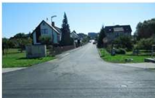
foto: Nová komunikace v ulici Za Rybníkem
