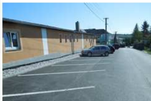
foto: Vybudování nového parkoviště u školního hřiště
