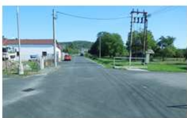
foto: Nová komunikace v ulici Sadová
