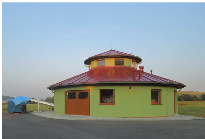
foto: Čistírna odpadních vod v Měčíně
