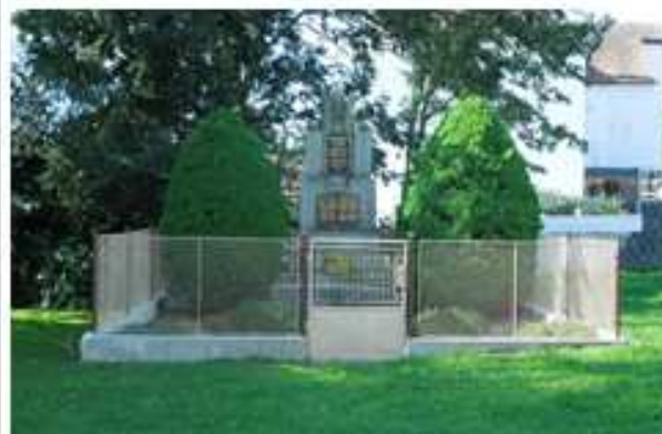
foto: Úprava pomníku a oplocení v Radkovicích
